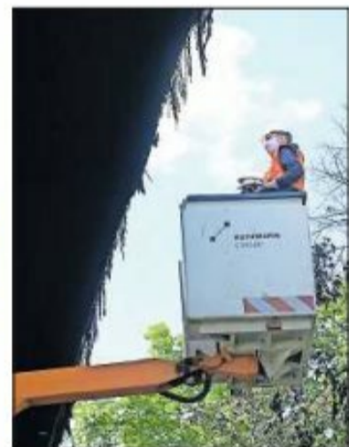
Untersuchung der Brückenteile, die durch die Hitzeentwicklung beschädigt sein könnten. FOTO: MORAY
